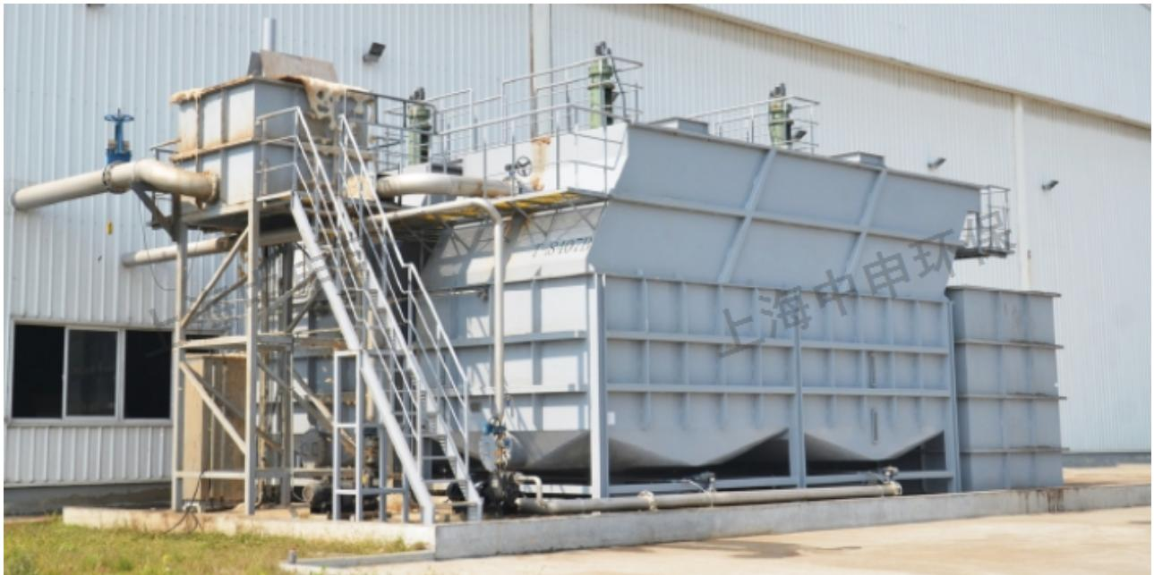
斜板沉淀池是根据浅池理论发展而来的，是一种在沉淀池内装置许多间距较小的平行的倾斜薄板的沉淀池，效果一般均较普通平流式沉淀池提高3-5倍，因而它在生产实践中取得了较好效果。特别是对散性颗粒的去除效果更为特别。给水处理的沉淀工艺是指在重力作用下，悬浮固体从水中分离的过程，原水经过投药、混合与反应过程，水中悬浮物存在形式变为较大的絮凝体，要在沉淀池中分离出来，以完成澄清的作用，混凝沉淀后出水浊度一般在10度以下。斜板沉淀池是根据浅池理论发展而来的，是一种在沉淀池内装置许多间距较小的平行的倾斜薄板的沉淀池。特点是沉淀效率高、池子容积小和占地面积小。斜板沉淀池沉淀时间短，故在运行中遇到水质、水量的变化时，应注意加强管理，以保证达到要求的水质[1]。从改善沉淀池水力条件的角度分析，由于斜板的放入，沉淀池水力半径大大减小，从而使雷诺数大为降低，而弗劳德数则很大提高，因此，斜板沉淀池也满足水流的稳定性和层流的要求。从而提高沉淀效果。
